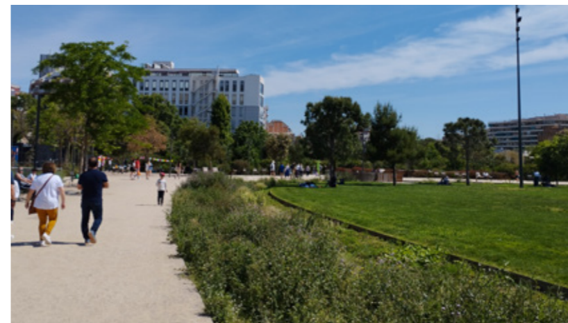
Plaza des les Glories Catalanes, Barcelona Swale, water filtration
